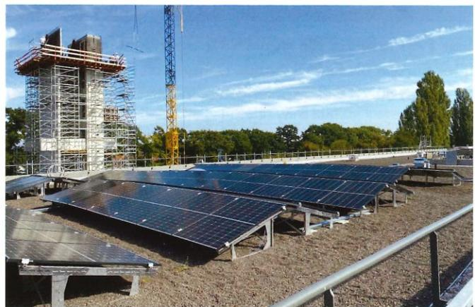
Mit dem Bau der PV-Anlage wurde eine Projektentwicklungsgesellschaft aus Berlin beauftragt. Zum Einsatz kommen 242 monokristalline Solarmodule (410 W Mono S4 Halfcut) der Firma Solarfabrik, die Wechselrichter sind von der Firma SMA (4 x SMA Sunny Tripower X25). Die voraussichtliche PV-Anlagenleistung beträgt 99,220 kWp, die jährliche Stromproduktion liegt damit bei zirka 85.000 kWh, was einer jährlichen CO<sub>2</sub>-Einsparung von etwa 60.000 Kilogramm entspricht.
